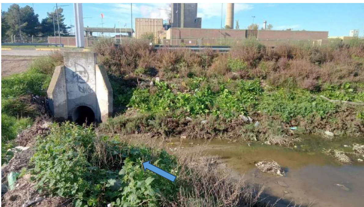
Foto 71. Segunda alcantarilla de desagüe frente a Central eléctrica Piedrabuena a bajo la RN 252 en barrio Boulevard
