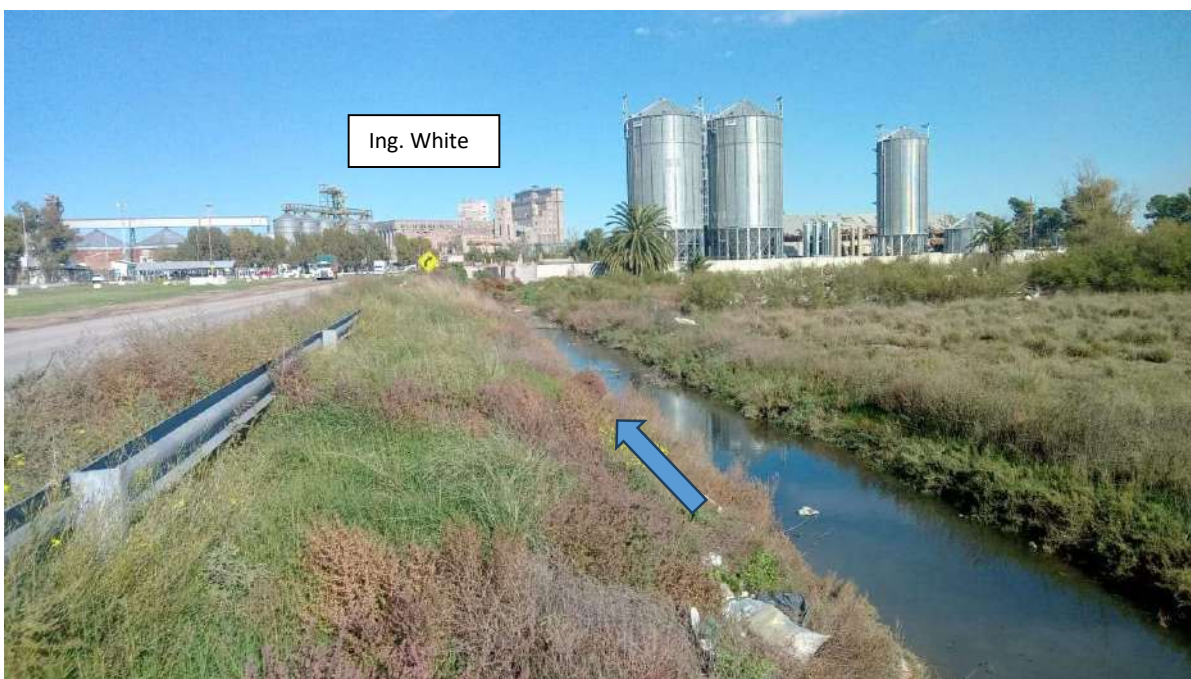
Foto 68, 69 y 70. Canal receptor paralelo a RN 252 de la margen del Barrio Boulevard
