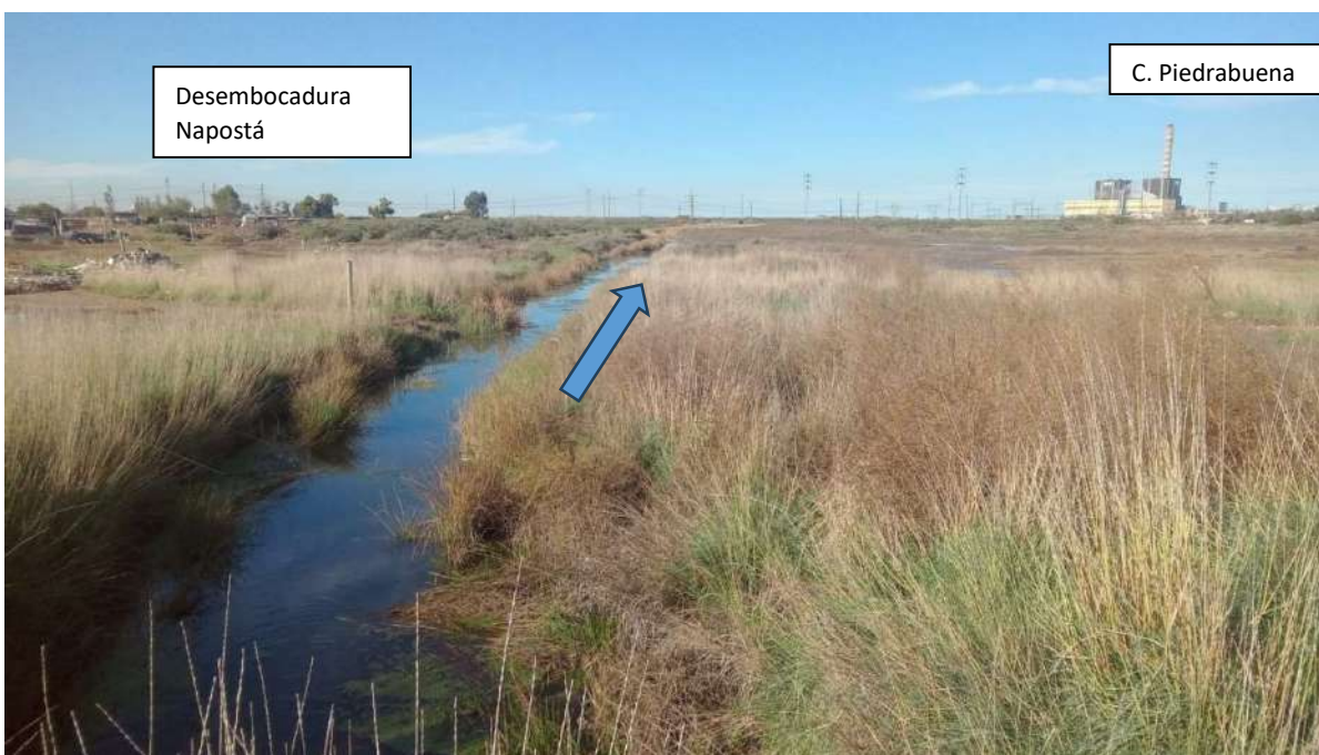
Foto 56 y 57. Puente sobre J.B. Justo y primer canal que cruza en sentido de la RN 252 hacia la desembocadura del Napostá
