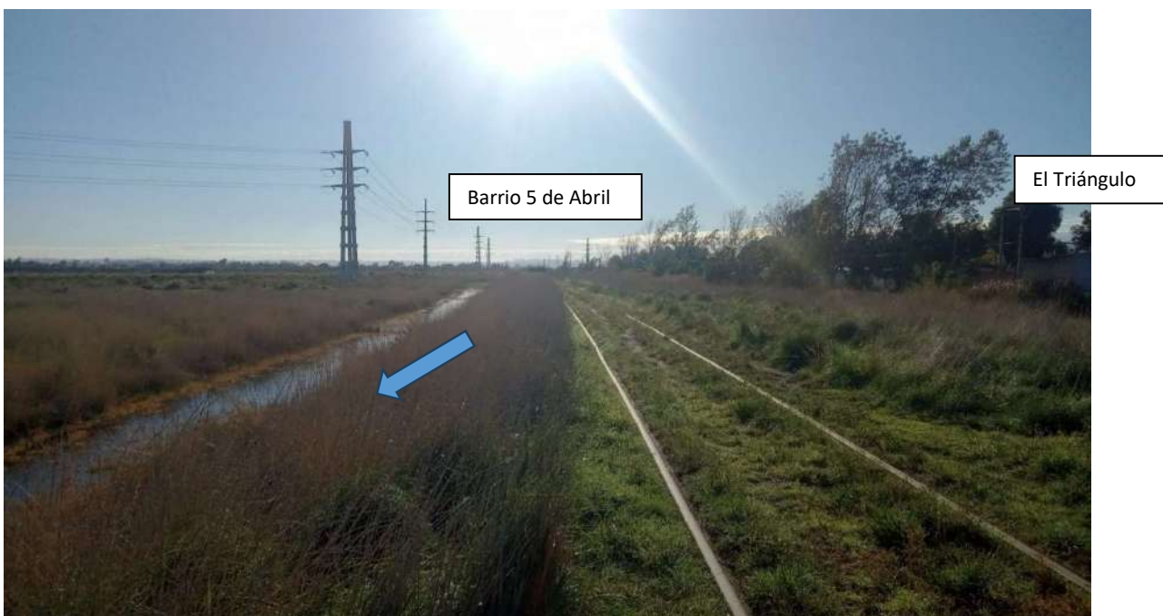
Foto 54. Canal derivador originado en Barrio 5 de Abril en las margenes de vias del ferrocarril paralelas a J.B Justo (B. Saladero ) entre RN3 sur en zona salida de El Triángulo
