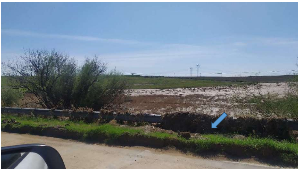
Foto 104 a 107. Erosión hídrica y procesos de sedimentación aguas arriba de RN3 km 12 por aporte de escorrentía del sitio 5
