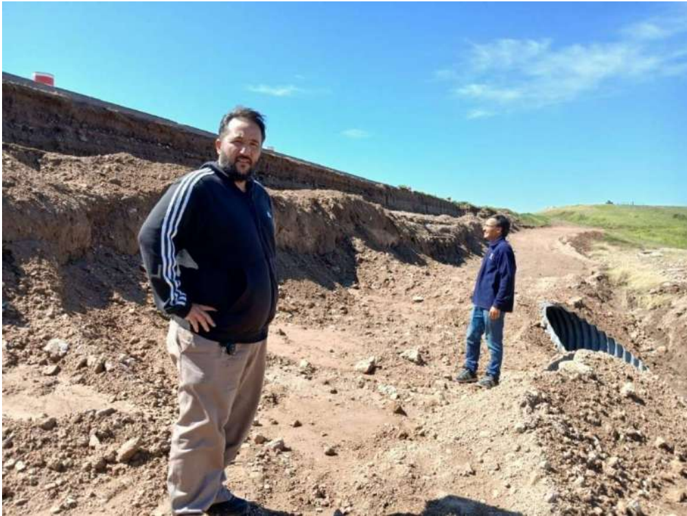
Foto 98 a 103. Socavamiento de RN 3 tramo nuevo (km 12) por la corriente de acumulación de agua de Calderón aguas abajo descrita en el sitio 5, en su curso hacia el mar.
