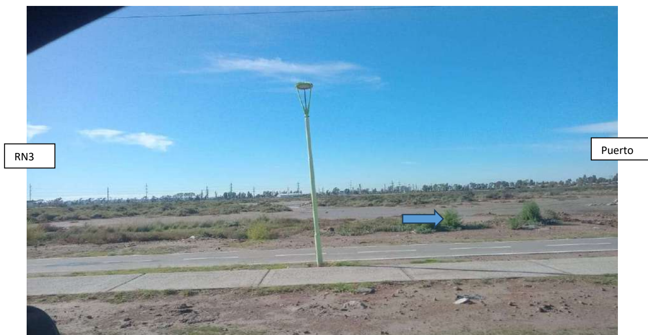
Foto 79. Av Santiago Dasso en Ingreso a Ing. White
