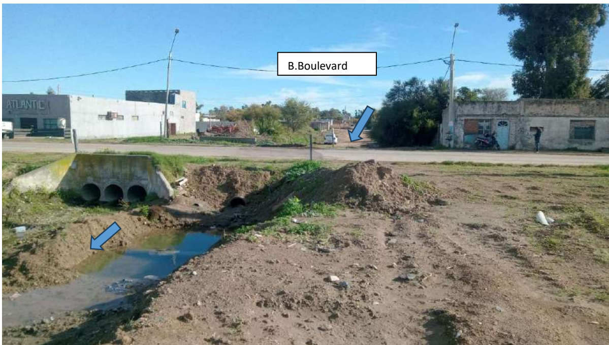
Foto 64 y 65. Alcantarilla de desagüe en barrio Boulevard a ambas margenes de la RN 252
