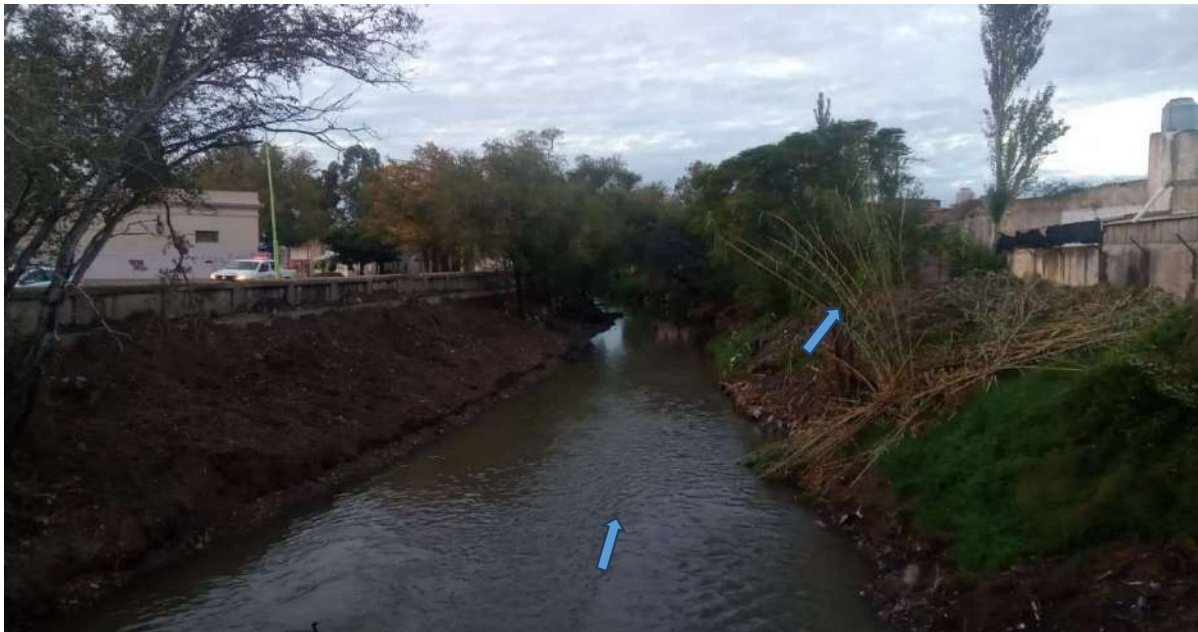
Foto 32 y 33. Final de parte entubada del arroyo Napostá en esquina de Estados Unidos y Brown
