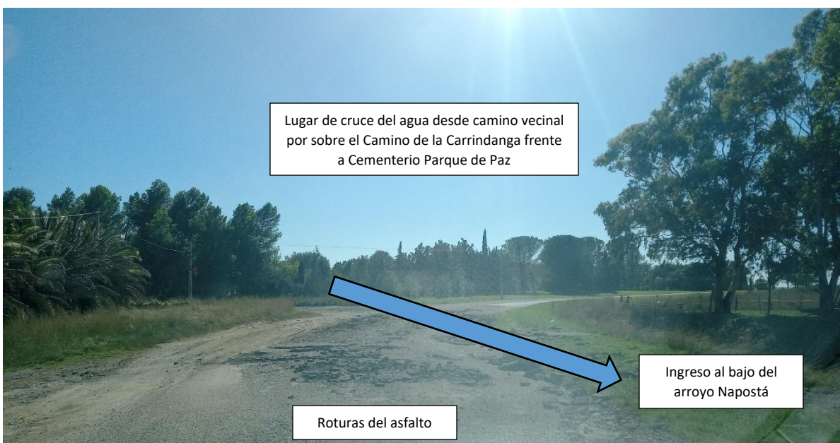
Foto 7. Sector del camino de la Carrindanga donde cruzó el agua de oeste a este hacia el arroyo Napostá y el asfalto fue arrastrado.
