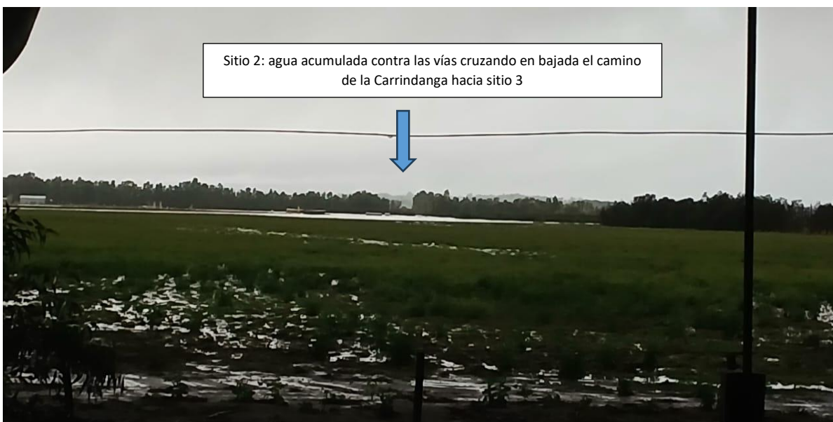
Foto 3. Vista en pendiente del Establecimiento San Carlos el 7-3-25 luego de la tormenta (18.00 hs) de la zona de cruce del escurrimiento de la Figura 7 por camino de la Carrindanga
