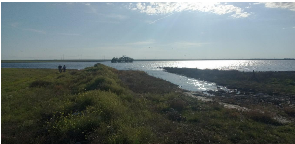
Foto 2. Canal vial de escurrimiento desmoronado con desagüe sobre esa llanura de inundación previa a la pendiente hacia el arroyo Napostá
