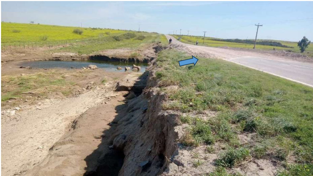
Foto 25, 26 y 27. Zona de corte, RN 35 km 20.
