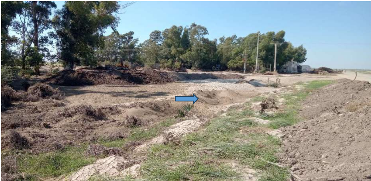
Foto 14, 15 y 16. Cruce Camino de la Hormiga- RN 35.
