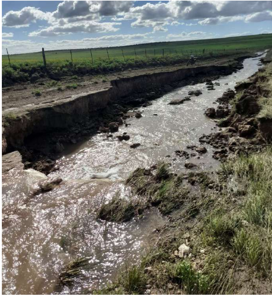
Foto 60 y 61. Formación de cárcavas en caminos rurales. Escorrentía en camino de la Hormiga y Est. La Cumbre a la altura de la naciente del Arroyo Saladillo de García. Gentileza Flia Trujillo.
