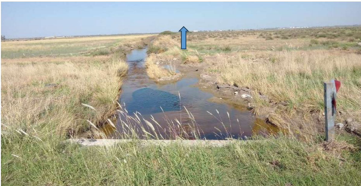
Foto 12 y 13. Cruce Saladillo chico, pasando el aeródromo Bahía Blanca sobre RN 35 sobre banquina norte y sur respectivamente.
